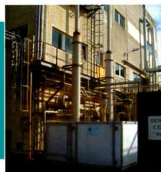
Unité modulaire pour traitement des COV par oxydation catalytique sur site industriel
